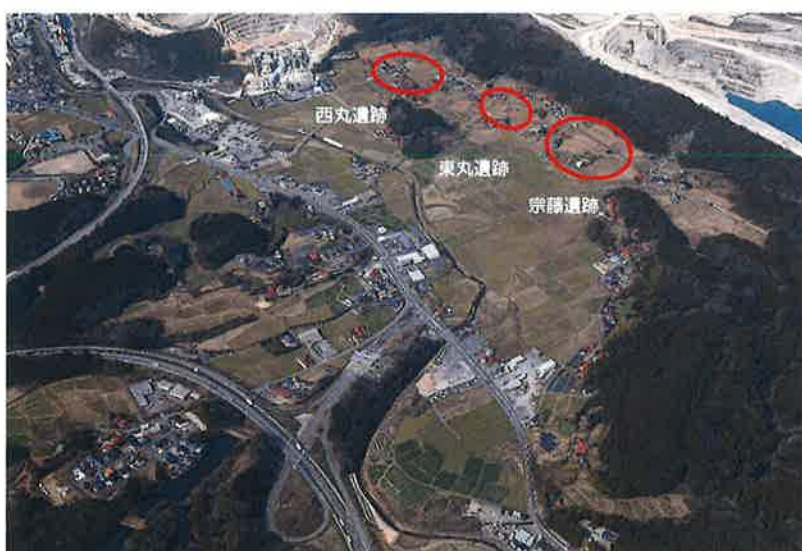
遠景（南東から）
